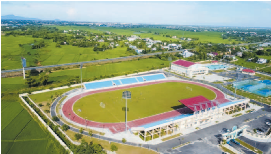
Trung tâm Thể dục - thể thao Bắc Quảng Nam do Cico 501 thi công xây dựng và lắp đặt thiết bị hoàn thành góp phần hoàn thiện hệ thống công trình kiến trúc, hạ tầng kỹ thuật hướng đến đạt các tiêu chuẩn của đô thị loại III trong tương lai
