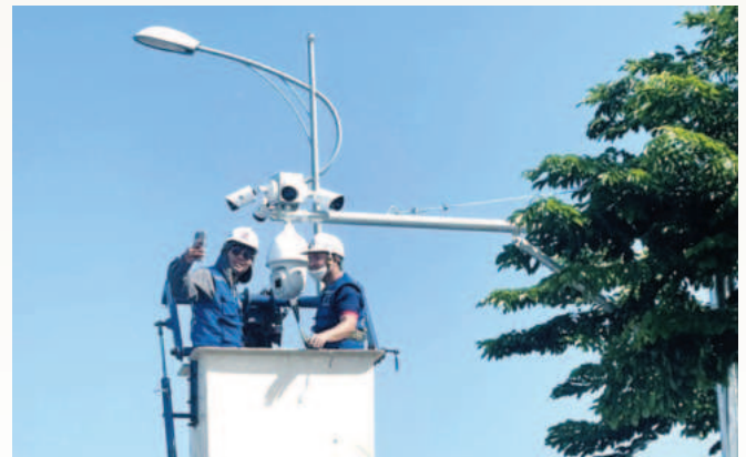
TP.Tam Kỳ triển khai lắp đặt và đưa vào vận hành hệ thống camera giao thông trên các trục đường chính trong thành phố
