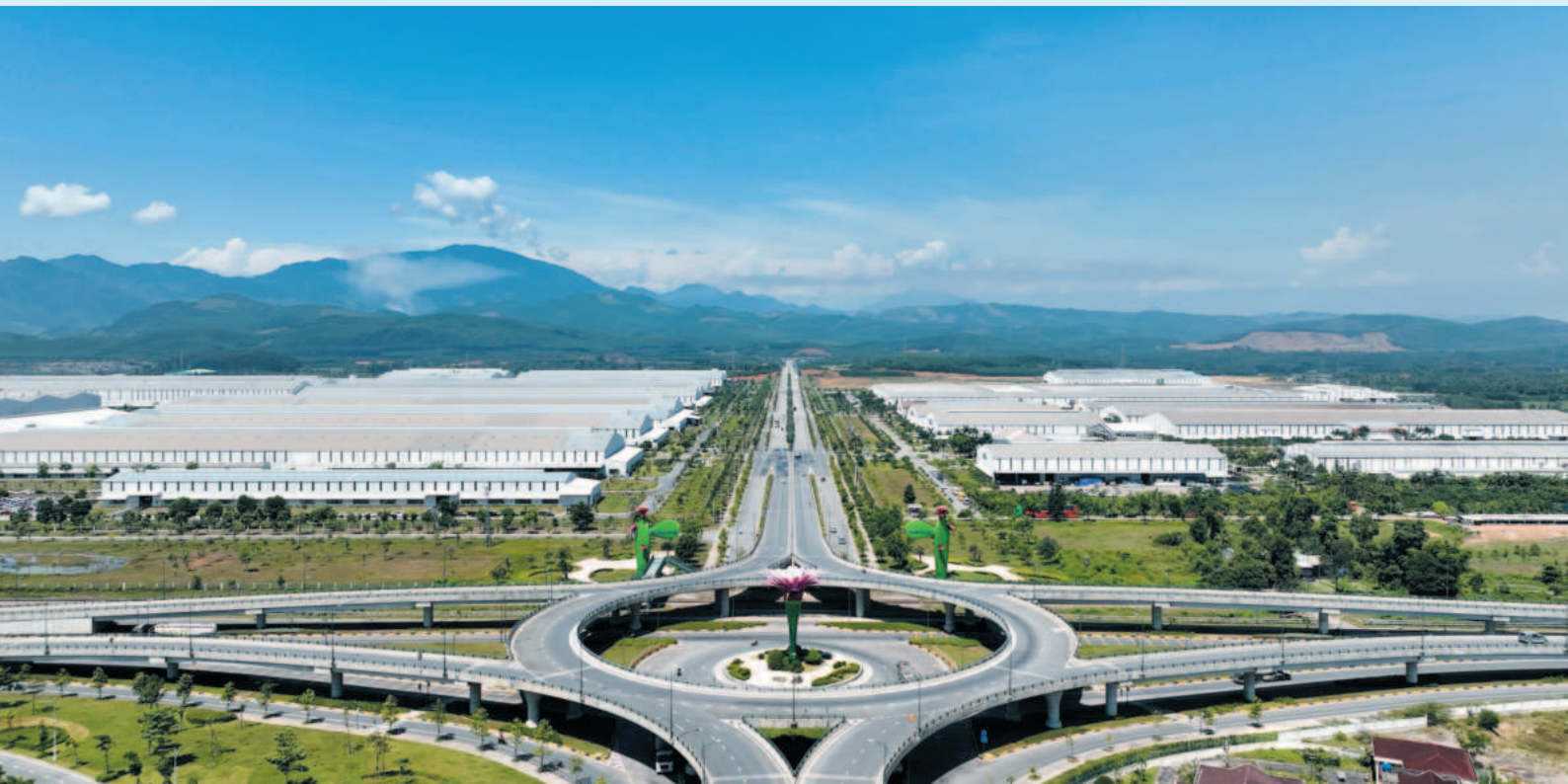
Khu công nghiệp Thaco Chu Lai
