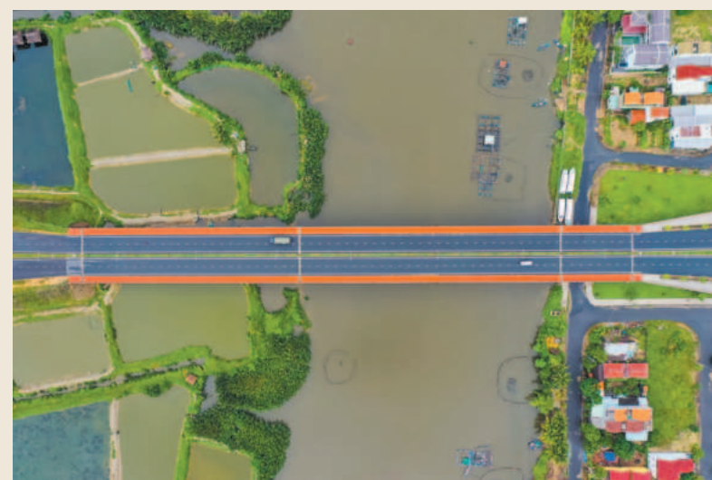
De Vong bridge, Hoi An
