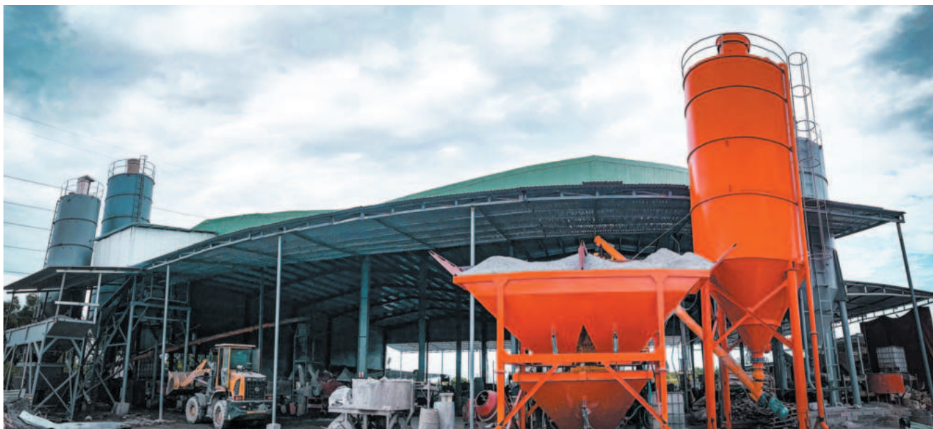
Nhà máy sản xuất Vật liệu xây dựng bê tông tính năng cao và bê tông siêu tính năng cao của Công ty TNHH Công nghệ Vật liệu Thịnh Miên Trung
